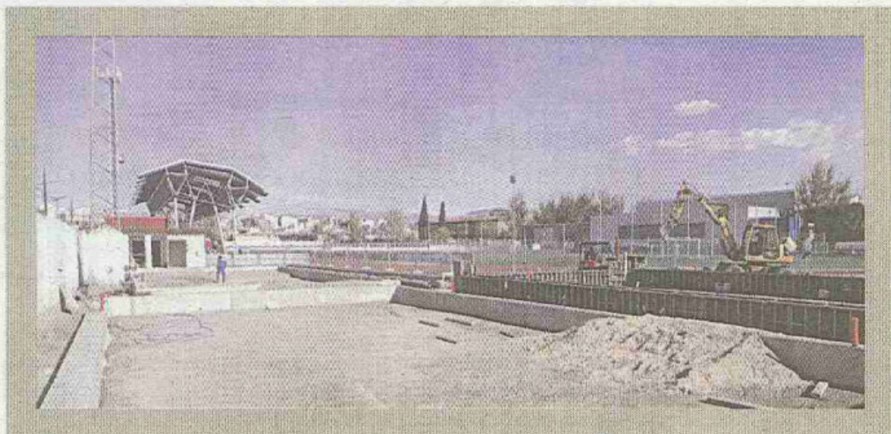
Pistas de pádel. Las obras están casi concluidas. JUAN PALMA
